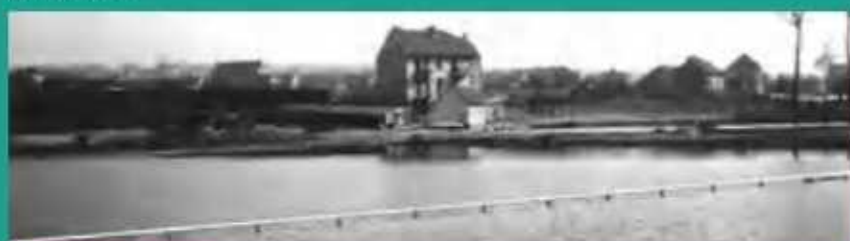
La piscine Schoeser
